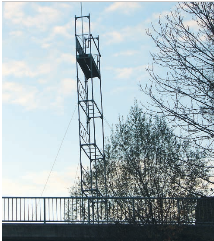
Kein Aussichtsturm zur Beobachtung der Flugzeuge: Seit kurzem steht in Guntershausen das Baugespann für die geplante Mobilfunkantenne von Orange.
